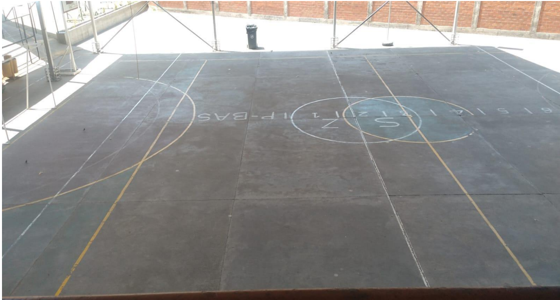
Fotografía Zona de Seguridad
